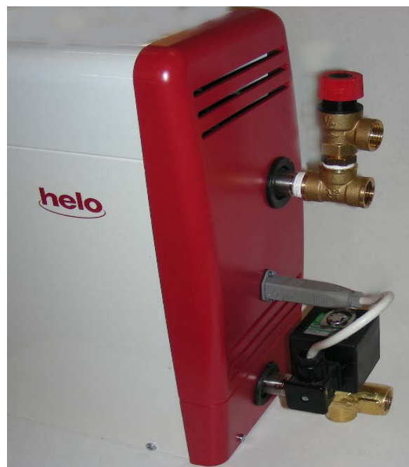
Bild. på montering av säkerhets och spolventiler
